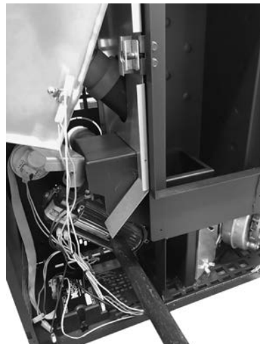
Fig. 69 - Pulizia ventilatore ambiente
