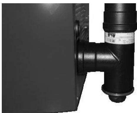
Fig. 64 - Pulizia canale da fumo
