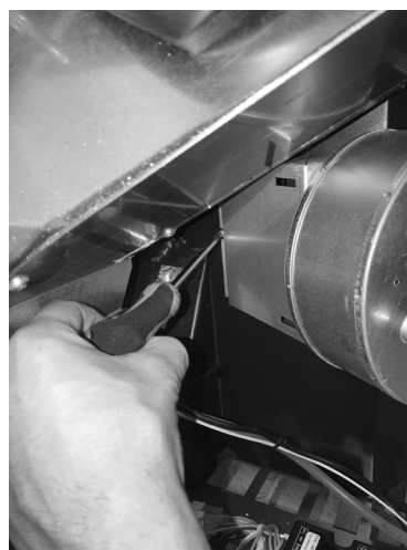
Fig. 30 - Rimuovere vite
