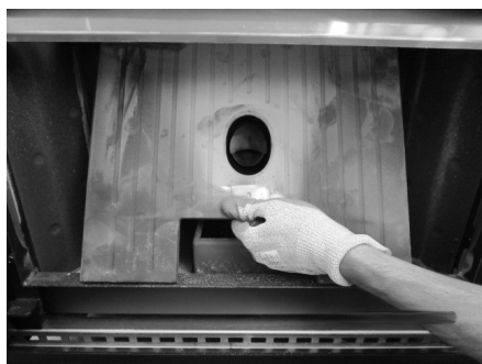
Fig. 39 - Rimozione ghisa centrale
